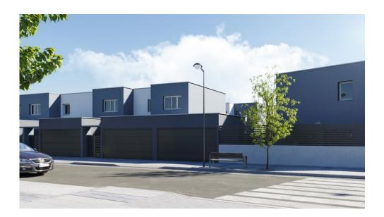
Revestimiento exterior: Aislamiento térmico con sistema SATE mediante paneles EPS de 120 mm de espesor; acabado con mortero decorativo con textura final a decidir por la D.F. y colores según alzados.
